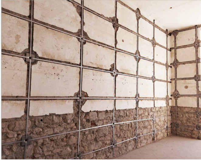
SCHEMA DI INTERVENTO SULLA MURATURA ESISTENTE
