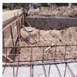
Trattasi della realizzazione di fondazioni in c.a., che possono essere di diverso tipo in funzione delle caratteristiche del terreno.
