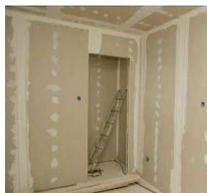
Trattasi della realizzazione di pareti divisorie in cartongesso, mediante l'assemblaggio delle lastre di gesso su orditura metallica portante, costituita da montanti e guide in acciaio zincato o in alluminio, ancorati alle strutture portanti del fabbricato. I pannelli di cartongesso sono legati con adesivi a base di gesso, sono stuccati per eliminare gli avvallamenti e sono poi carteggiati con la cartavetro, per poter essere pitturati.
