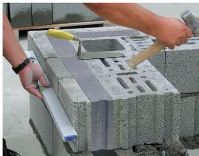
L'attività consiste nella realizzazione di murature in mattoni tipo lecablocco, ossia manufatti in calcestruzzo alleggerito con argilla espansa, che permettono di realizzare murature ad isolamento diffuso, ed in particolare:
