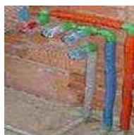
La fase lavorativa prevede la realizzazione della rete generale di distribuzione acqua fredda, posa tubazioni, colonne montanti di distribuzione di acqua fredda e calda ai singoli apparecchi del bagno, collettori di scarico dei singoli apparecchi sino alla colonna di scarico; montaggio degli apparecchi sanitari, rubinetterie, sifoni e pilette.
